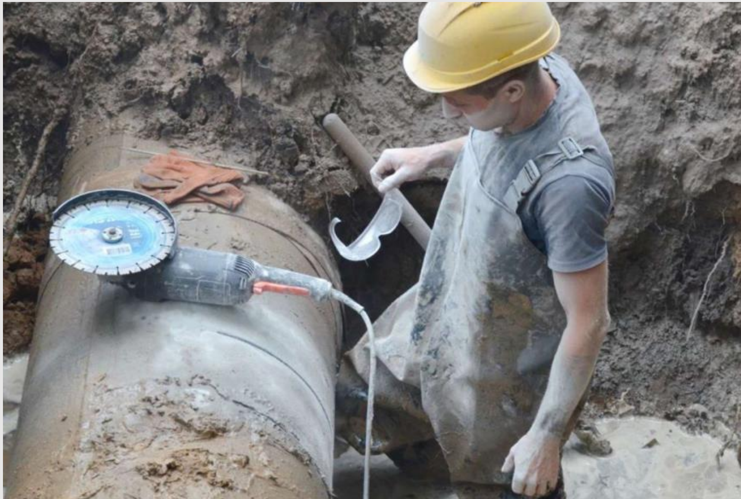
ВІДНОВЛЕННЯ ВОДОМЕРЕЖІ ТА ВОДОВІДВЕДЕННЯ
